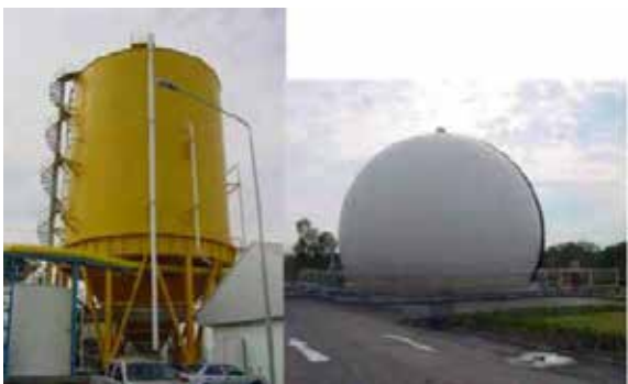
ถังย่อยสลายแบบไม่ใช้ออกซิเจนและถังเก็บก๊าซชีวภาพ
